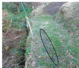
農道(幅はおよそ1.4m)を上から見たところ(黒円のところに木板を敷いていた)
